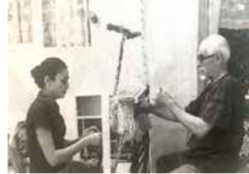
Fotoğraf 4. Haşillama, çerçeveye (keşken) iplerin bağlanması, perdah hazırlanması (Ertekin, 2006:17-21).
